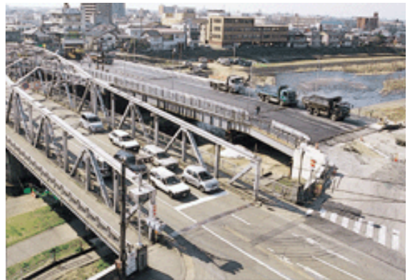
旧橋(手前)と工事中の仮橋(奥)
