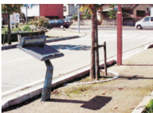
歩道のモニュメント設置
