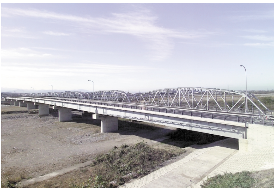
辰口橋全景 (旧橋トラス橋は、平成15年度~16年度に撤去予定)
