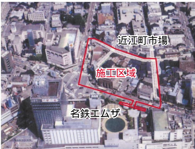
[ 武蔵ヶ辻第四地区現況 ]
