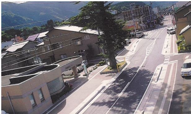
整備完了後の鳥瞰風景
