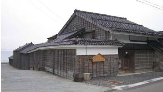
県指定文化財の角海家住宅（現在改修工事中）
