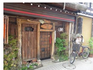
町家を利用し居酒屋に改修
