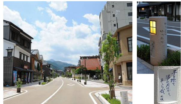
土のみちをイメージした車道舗装
