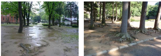
— 再整備前の写真 —
