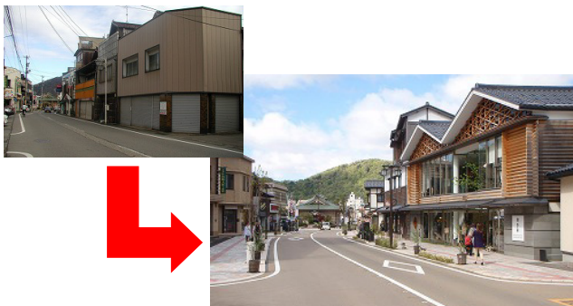
整備前後の沿道状況
