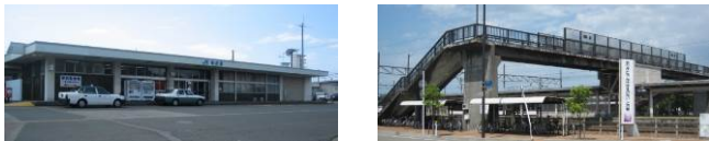
▲ 老朽化が進んだ駅舎と人道跨線橋
