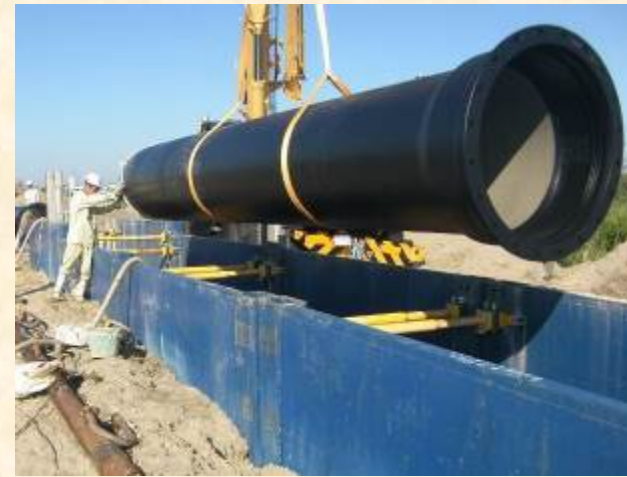
写真-2 送水管設置状況
