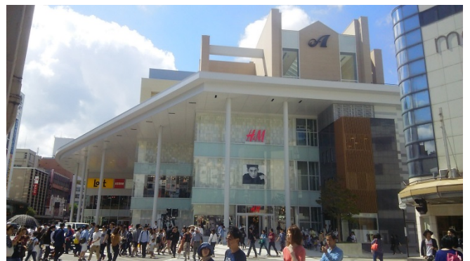
整備後の「片町きらら」
