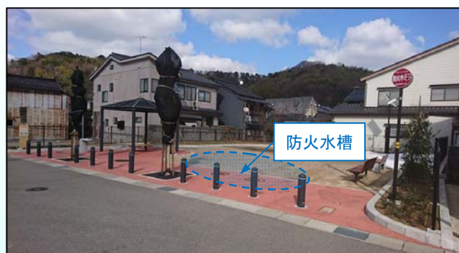
— 防災広場の整備（防火水槽の設置） —
