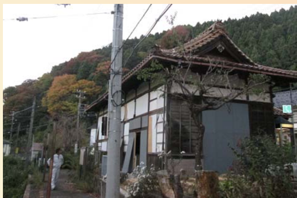
▲ 廃線後改修前の駅ホーム・線路跡
