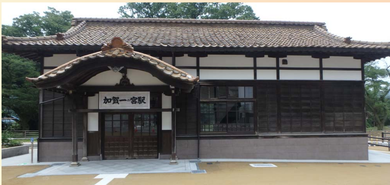
▲ 改修後の旧加賀一の宮駅舎
