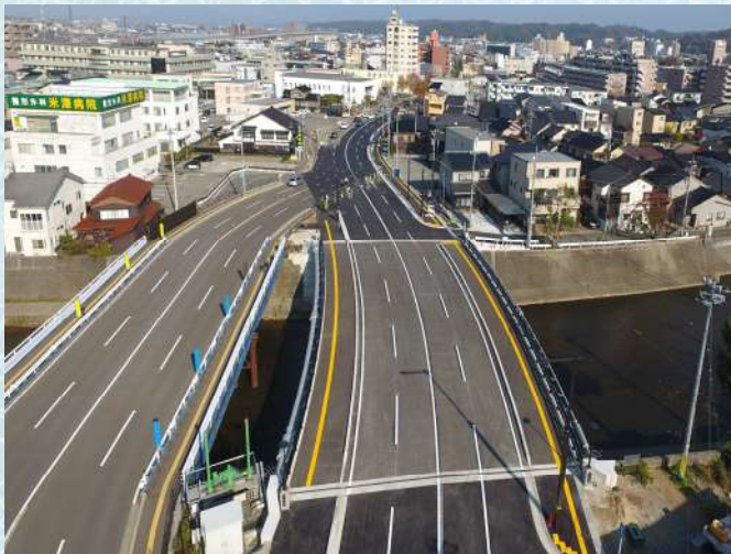
▲ 中島大橋 (新橋完成時)
