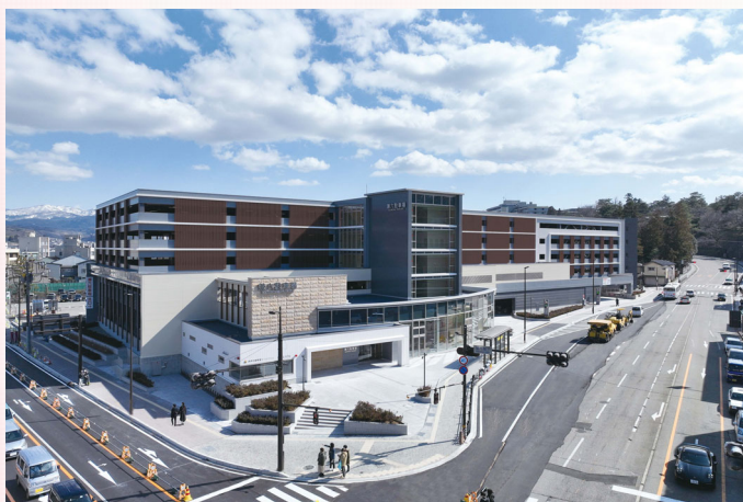
写真1 完成した兼六駐車場（令和5年3月完成）
