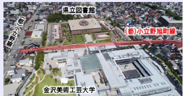
▲(都)小立野旭町線完成(令和 5 年 8 月)
